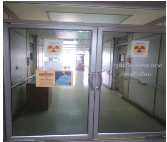
รูปที่ 7 แสดงการติดป้ายสัญลักษณ์รังสีสากลและป้ายห้ามเยี่ยม
